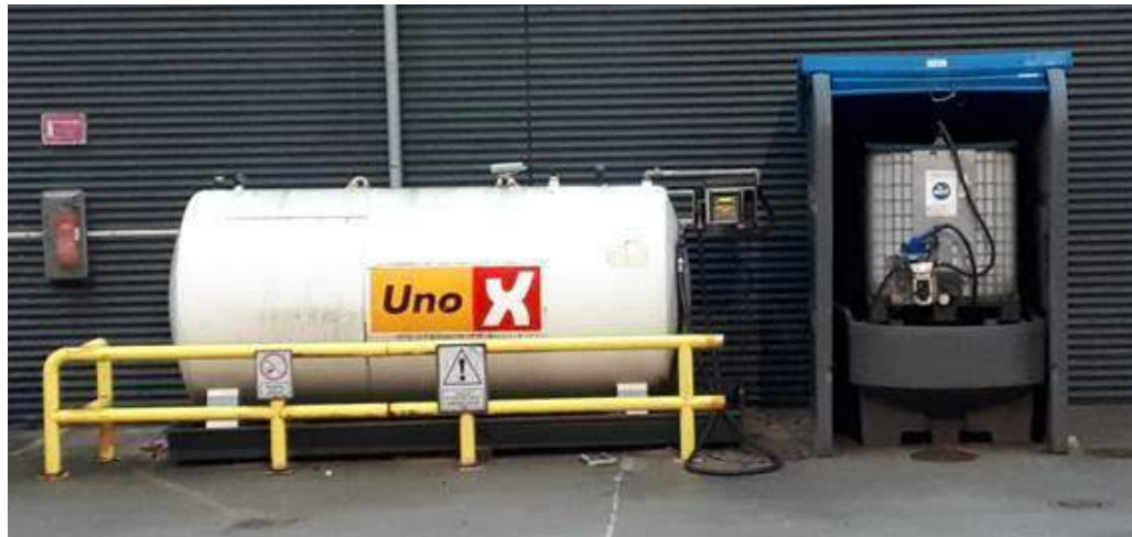
Figure 8 : exemple de cuve de stockage de carburant et de container d'AdBlue® / ©Siemens
