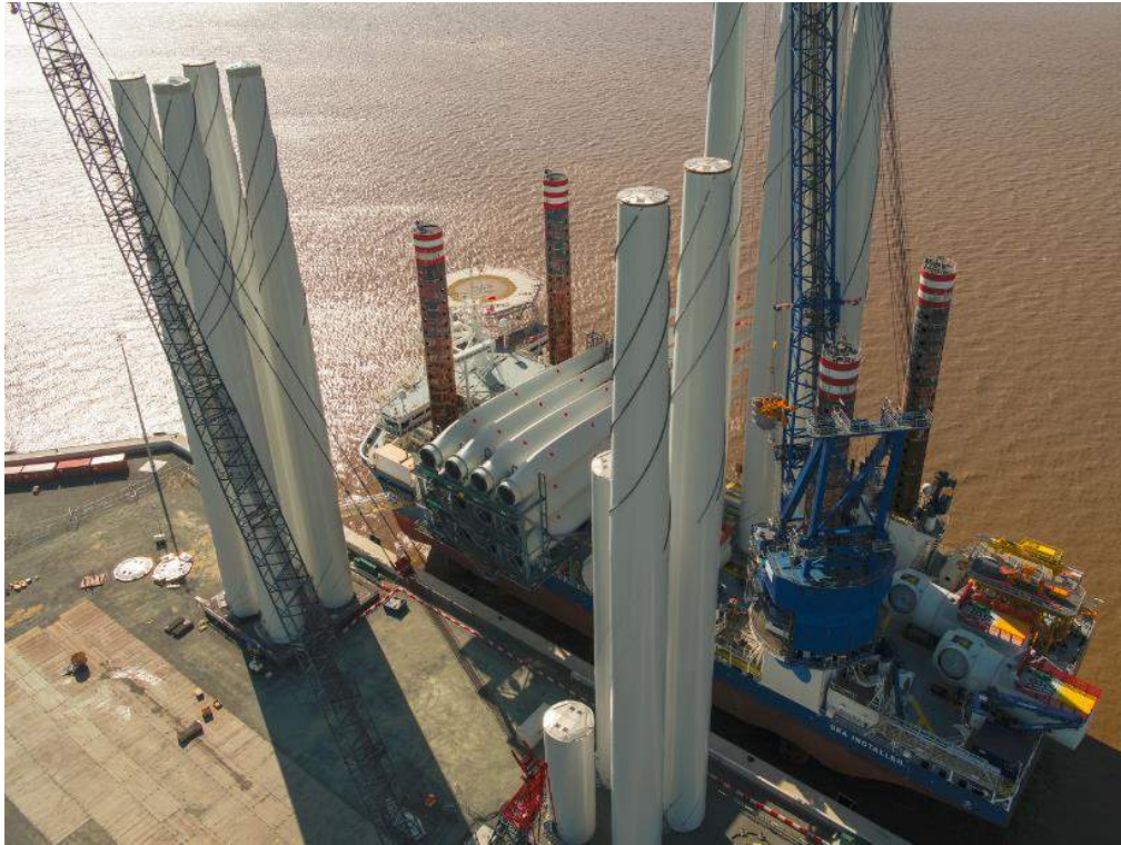
Figure 65 : pré-assemblage des tours et chargement du navire jack-up / ©Siemens Gamesa
